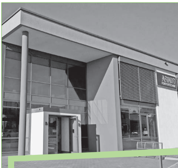
Das neue Kundencenter von Arndt Fenstertechnik.
